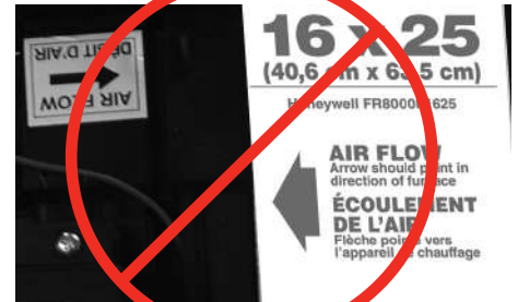
Fig. 18: cerciórese de que las flechas del filtro estén orientadas en la misma dirección que la flecha en el módulo de mejoramiento. Esto deberá estar en la misma dirección del flujo de aire.
