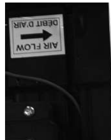
Fig. 18: cerciórese de que las flechas del filtro estén orientadas en la misma dirección que la flecha en el módulo de mejoramiento. Esto deberá estar en la misma dirección del flujo de aire.
